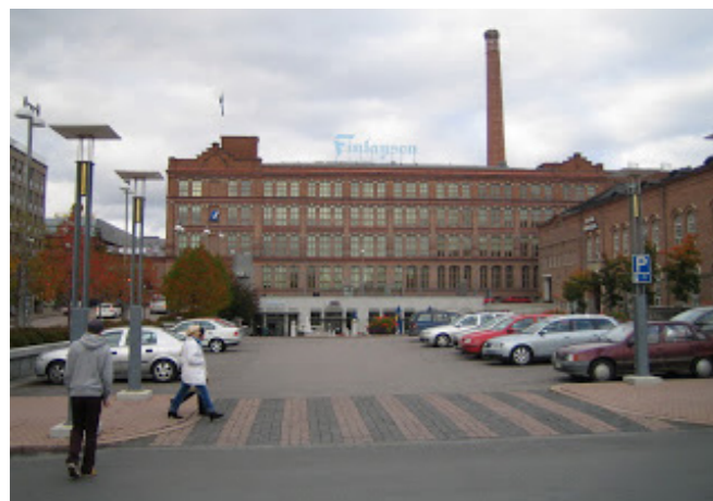
Näkymä pohjoiseen kohti Finlaysonin aluetta.
