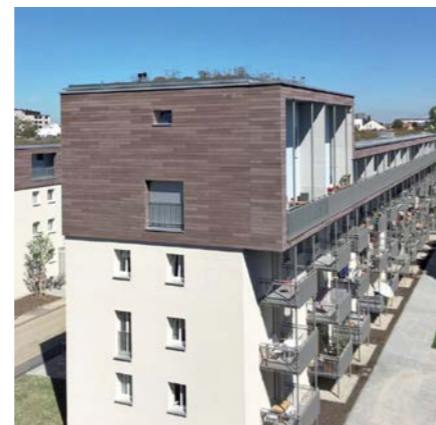
Esimerkki rakennuksen korottamisesta kevytrakenteisella puurakentamisella (valokuva: Spittelmeister München).
